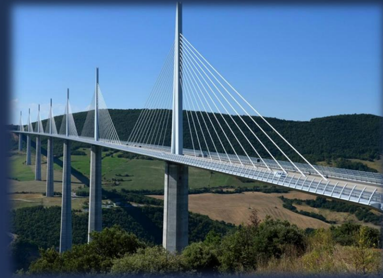
Das Viadukt von Millau in Frankreich wurde mit 0,025% Niob konstruiert. Dadurch reduzierte sich das Gewicht des verbauten Stahls und Betons um 60%. Quelle: CBMM
